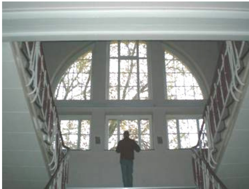
Haupttreppenhaus GY Ricarda-Huch-Schule
