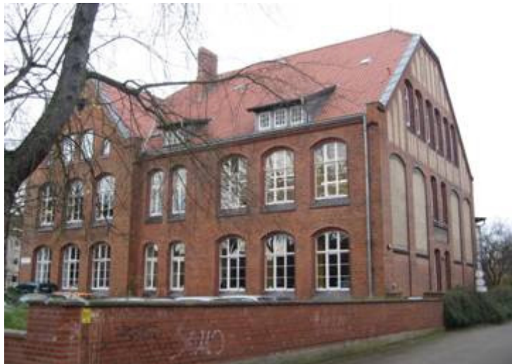
GS Am Stöckener Bach, keine Fassadensanierung (50% Energieeinsparung)
